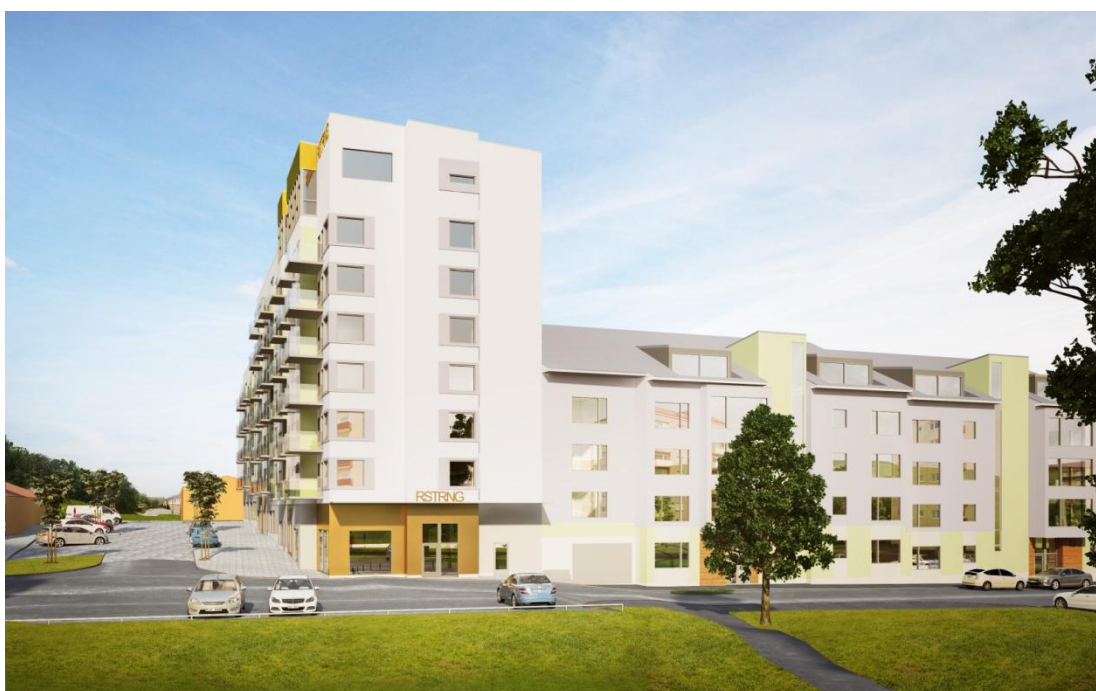
Vy mot Stortoppsgatan där kvarteret byggs samman. (Tengbom).
