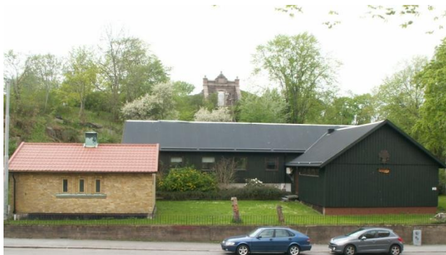
Pumpstation och föreningslokal som kommer att rivas för att ge plats för den föreslagna bebyggelsen
